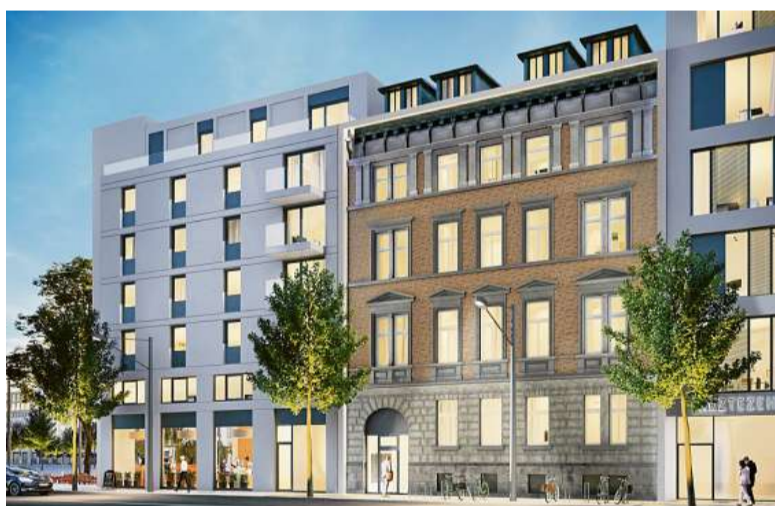
Die denkmalgeschützte Fassade am Ritterbrunnen soll betont werden.
